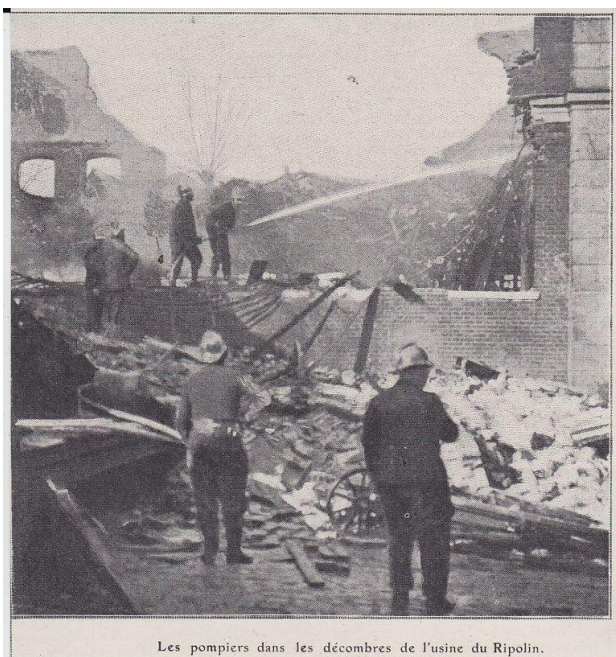
Les pompiers dans les décombres de l'usine du Ripolin.
